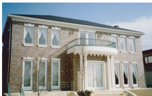
腐食に強いダグラスファーを使用し、24mm厚の床板や2×6の柱を標準仕様とした2×4工法のN邸。住み心地の良さと美しいデザイン性が両立
